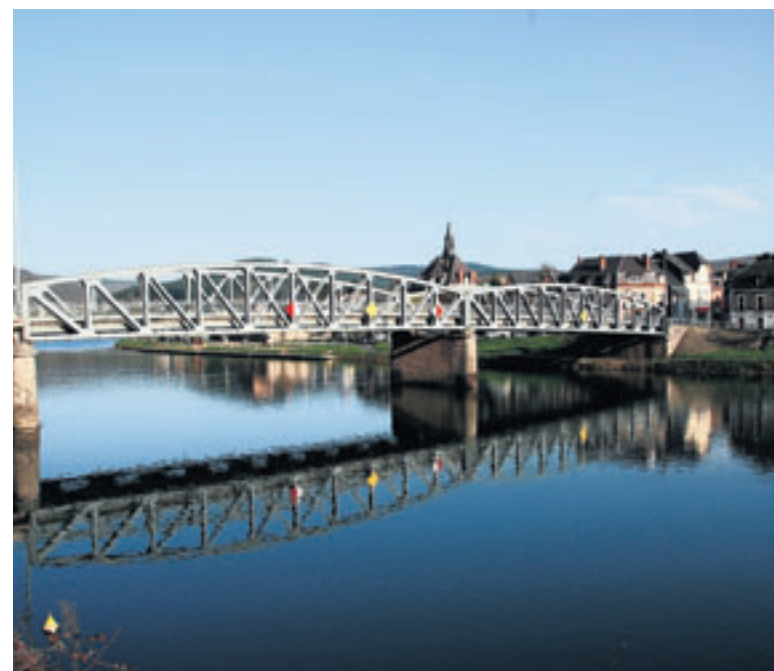
Brug over de Maas bij Haybes.
