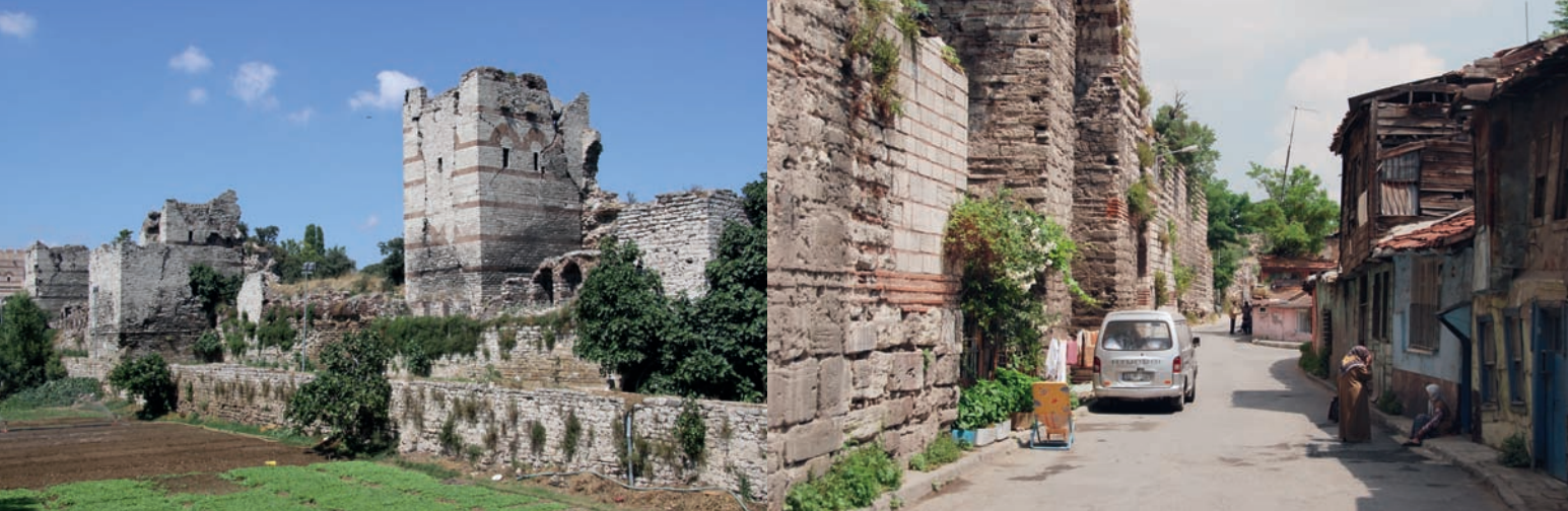
Links: Hele grote stukken muur verkeren in deplorabele staat. [foto: Coral Press]
