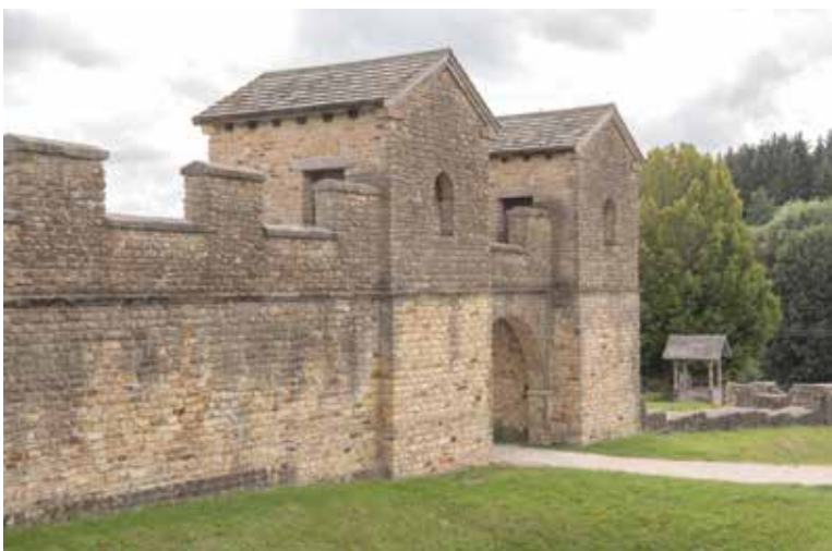
▲ Reconstructie toegangspoort castellum Welzheim-Oost.
